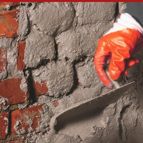
Produit pré-mélangé monocomposant pour la réalisation d'enduits respirants et déshumidifiants par simple ajout d'eau au mélange, préparatoires à l'application d'enduits rénovateurs, déshumidifiants, calorifuges et anticondensation ; concrètement, Intosana, Sanatigh, Sanawarme et Caleosana, enduits conçus spécifiquement pour la salubrité des bâtiments neufs, des bâtiments existants, des travaux de bioconstruction et de la restauration des bâtiments historiques et monumentaux.
