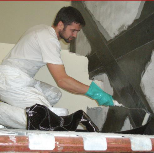
TECHNOKOMPOSIT est l'acronyme pour des systèmes étudiés justement pour exécuter des renforts et des consolidations structurelles d'édifices sujets à de sérieuses dégradations, même à cause d'événements telluriques, par l'utilisation de la technologie des systèmes composites (FRP - FRCM) à base de fibres de carbone, basalte, verre et aramide.
