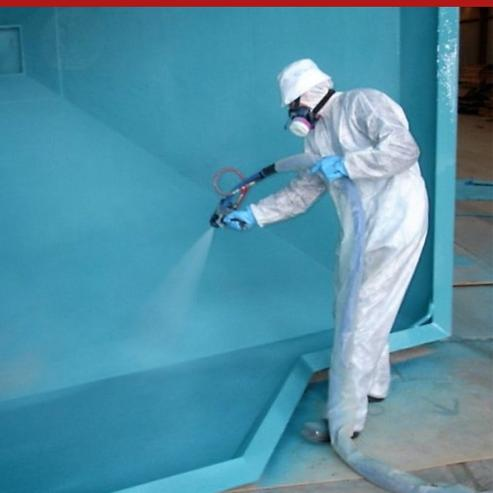
SYNTECH POLIUREA PRIMER - EPOXY METAL est un primaire à deux composants sans solvant à base de résines époxydiques utilisé comme promoteur d'adhésion, scellant de surface pour le béton, à appliquer comme substrat pour les travaux avec des polyuréés sur des surfaces métalliques et des revêtements époxy et polyuréthanes.
