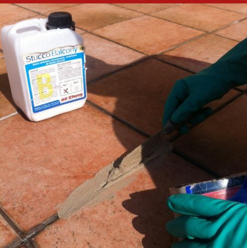
Coulis de ciment fin à deux composants, de consistance plastique fluide, pour le jointoiment des joints non recouverts, le remplissage et le lissage des fissures statiques, des micro et macro-cavités, etc. entre les carreaux qui composent le revêtement, avant l'application de Protech Balcony en travaux d'imperméabilisation transparente non pelliculaire sur les terrasses et les balcons.
