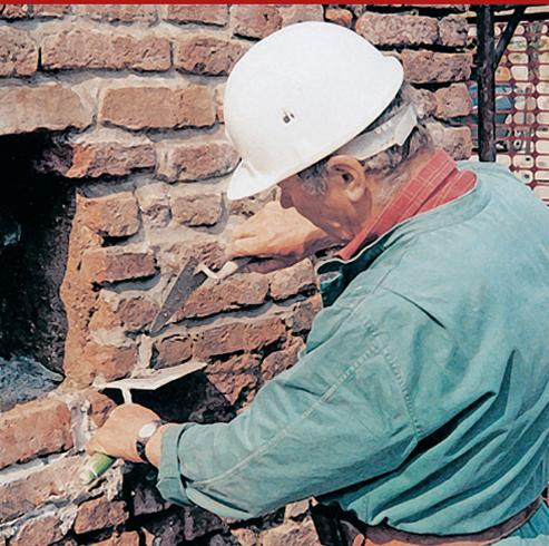
Mortier adhésif à haute perméabilité et de modélisation, à base de chaux hydraulique, pour combler les fuites entre les éléments en pierre, brique, moulures, objets décoratifs, etc., dans les constructions écologiques, les nouvelles constructions et la restauration des bâtiments et monuments historiques. Il peut être ajouté avec des terres colorantes, agrégats décoratifs, etc.
