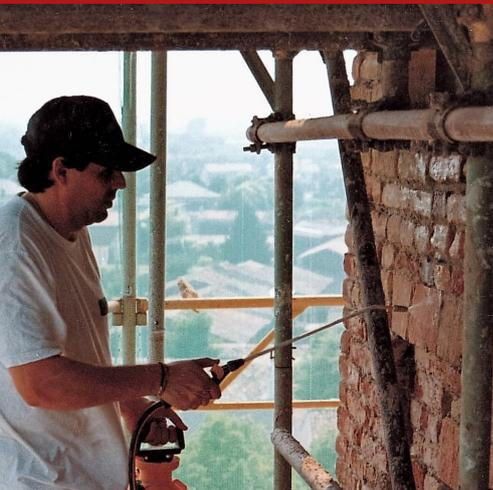
Solution réactive de silicates minéraux capables de former, par réaction avec les sels et hydrates de calcium présents dans la maçonnerie, composés de liants et stabilisants, spécifiques pour le traitement de durcissement, préliminaire aux opérations successives d'enduit ou de rasage, d'enduits, mortiers et pierre de verse pulverulent et d'enveloppes du mur en général, dans les constructions écologiques et la restauration de bâtiments et de monuments historiques.
