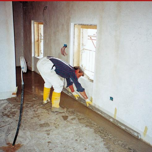
Chape praticable à base de chaux hydraulique, de granulats silico-calcaires d'une granulométrie maximale de 5 mm et de granulats légers à activité pouzzolanique, renforcée de fibres de polypropylène et de microfibres de verre, utilisée pour la construction, avec apport d'eau, de chapes résistantes et substrats, dans les interventions de construction écologique et dans la restauration de bâtiments d'époque et monumentaux.
