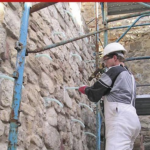
Préparation en poudre, prêt à l'emploi, à base de chaux hydraulique, pour la préparation, avec seulement l'addition de l'eau, des coulis pour la consolidation de mur, injectable et coulable, de très hautes performances en termes de glissement, durabilité et stabilité, dans les constructions écologiques et dans la restauration des bâtiments et monuments historiques.
