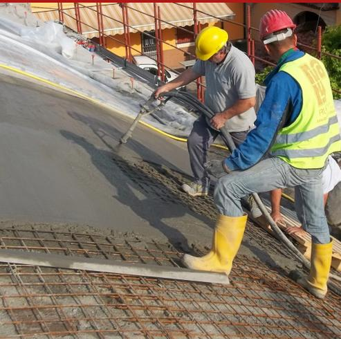
Mortier cimentaire structural, thixotrope, haute performance, fibré avec un mélange de microfibres métalliques (longueur = 6 mm, diamètre = 0,22 mm) et de microfibres synthétiques résistantes aux alcalines, utilisé pour la restauration et l'épaississement des structures en béton armé et en maçonnerie, même dans des environnements d'exposition sévères (marins, industriels, cycliquement secs et humides).
