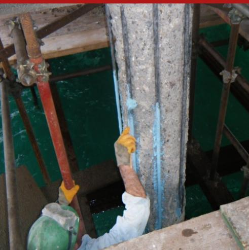
Ciment bi-composant, modifié avec des résines flexibilisantes et de spécifiques agents anti corrosion pour le traitement passivant du fer d'armatures oxydées, dans le rétablissement du béton dégradé.
