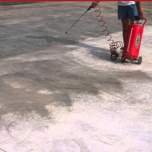
Durcisseur revitalisant chimique/mécanique, anti-poussière, pour sols et chapes en béton, constitué d'une solution aqueuse de silicates et fluosilicates minéraux, activée par des agents mouillants spéciaux. Il s'applique en plusieurs couches, avec une dilution décroissante dans l'eau, au balai ou à l'autolaveuse mécanique. Spécialement formulé pour le dépoussiérage des sols industriels ou des chapes en béton qui ont perdu leur « vitalité » d'origine.
