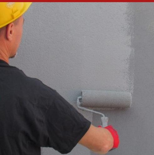
Finition colorée monocomposant en dispersion aqueuse pour la protection opaque des surfaces en béton et supports cimentaires, des revêtements muraux et des sols convenablement préparés et apprêtés. Le produit est un système de peinture adapté aux environnements avec présence d'aliments, qui peut être utilisé pour protéger les murs et les plafonds conformes au protocole HACCP, afin d'éviter une éventuelle contamination alimentaire.
