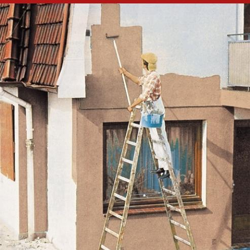
Peinture imperméable, transpirante, pigmentée, à base de résine siloxane en dispersion aqueuse pour le teintage imperméable dans l'assainissement d'édifices civils, industriels et de nouvelle construction. Vivement conseillé pour finition de protection transpirante imperméable d'enduits déshumidifiants macro-poreux. Sanatigh, Sanawarme, Caleosana).
