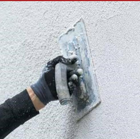
Revêtement plastique continu spatulé pour intérieurs et extérieurs, de haute qualité et facile à appliquer; à base de pigments inaltérables hautement couvrants, d'inertes siliceux, de grenaille de marbre à granulométrie contrôlée dispersée en liant à base de résine acrylique en émulsion aqueuse.
