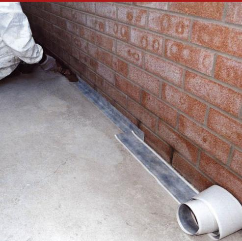
Ruban adhésif, à froid, hydrofuge, composé d'une couche à consistance viscoélastique en caoutchouc butyle, recouvert d'un tissu non-tissé, en polypropylène, pour l'étanchéité des joints non structurels pour les balcons, terrasses, etc. Dimensions de la bande 80 mm x 0,9 mm.
