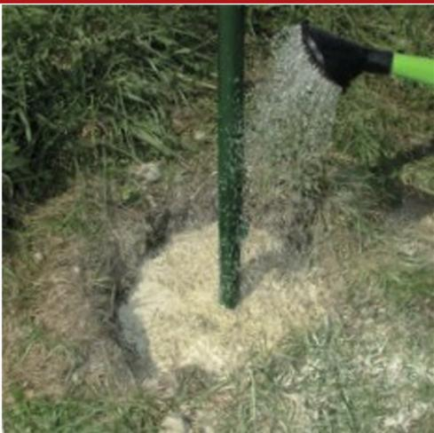
Mortier cimentaire à prise rapide pour assembler et fixer des poteaux de clôture, corde à linge rotative, etc..., dans des trous pratiqués dans le sol... sans mélange avec une perceuse, un fouet, une bétonnière ou autre.
