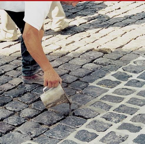
Micro mortier anti-retrait à base de ciment, coulable, autonivelant, superadhésif, à base de ciments à haute résistance, de charges superpozzolaniques, de stabilisateurs polymères, d'agents anti-retrait. Agrégats d'une taille maximale de 0,35 mm. Idéal pour remplir les joints (lacunes et/ou interstices) des dalles urbaines en porphyre ou en pierre, même de grandes dimensions. Remplissage des fissures et des lésions dans les structures en béton et en maçonnerie.
