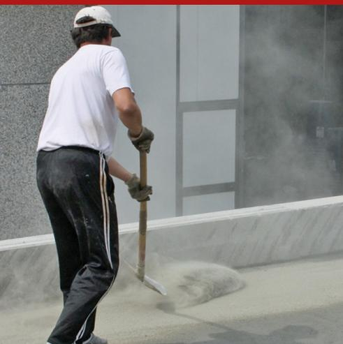
Mélange minéral pré-mélangé de durcissement à base de basalte, corindon, quartz de haute pureté, réactifs superpozzolaniques (microsilicates épaissis) et liants hydrauliques, pour le revêtement de surface des sols industriels en béton.
