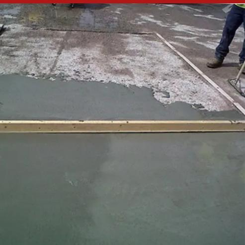
Floor Level SFR est un mortier cimentaire autonivelant, polymère modifié, renforcé de fibres Readymesh MR-060, à prise accélérée et à durcissement rapide, utilisable pour des régularisations planes d'une épaisseur allant de 3 mm à 25 mm, avant la pose du revêtement de sol. , ce qui le rend apte à recevoir tout type de revêtement.
