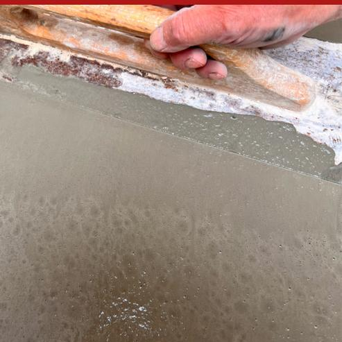
Floor Level est un mortier ciment, polymère modifié, fibro-renforcé, à prise et durcissement rapides, utilisable pour régulariser le lissage avec un intervalle d'épaisseur de 3 mm jusqu'à 20 mm, pour préparer parfaitement les sols à recevoir n'importe quel type de revêtement.
