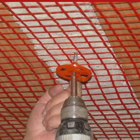
Bride de fixation en nylon (58 mm de diamètre et 40 mm de longueur) avec une vis autotaraudeuse en acier galvanisé résistant à la corrosion (30 mm) pour la connexion des filets ARMAGLASS STRUCTURA dans les systèmes anti-fissures RINFOR SYSTEM 1 et 2.
