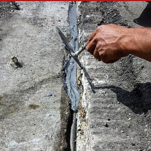
Produit de scellement époxy-polyuréthane à deux composants, élastoplastique, thixotrope, pour joints soumis à la circulation : dureté Shore A = 65 ; allongement à la rupture 70% ; à appliquer à la truelle ou à extruder dans les sections du joint, convenablement tapissé (pour protéger les surfaces adjacentes). Résistant au contact avec les hydrocarbures (essence et gazole).
