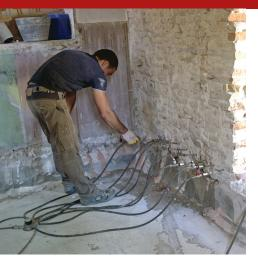
Solution de résines spéciales de silicone modifiées, dispersées dans de l'eau, hydrophiles pendant la phase d'application, hydrofuges après réaction avec du dioxyde de carbone atmosphérique.
