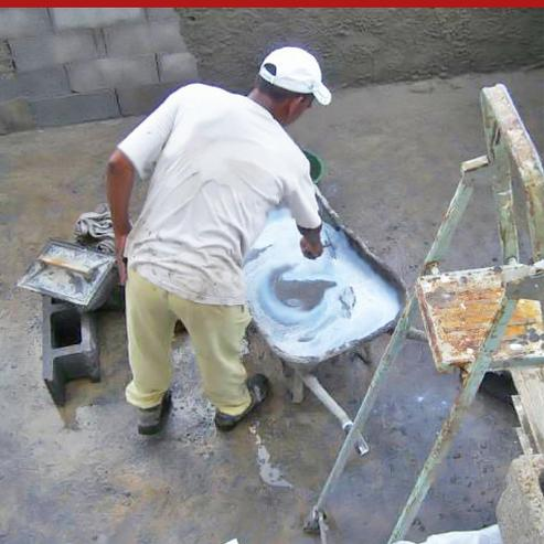
Latex adhésif à base de caoutchouc élastomère styrène-butadiène et silicate alcalin en dispersion aqueuse, flexible, réactif, pour coulis de ciment d'adhérence et pour améliorer l'adhésion, le comportement et les prestations des mortiers et enduits.
